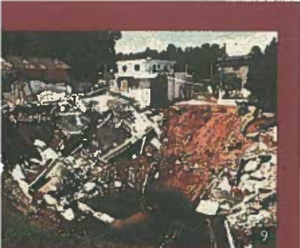
Foto 9 – Situação estabilizada da dolina de Cajamar, com afloramento do nível da água no fundo (Teixeira et al, 2000)
